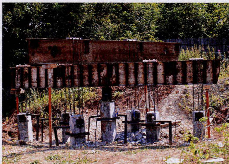
Рис. 2. Стенд для испытания свай статической нагрузкой
